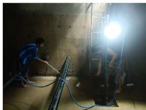
การล้างทำความสะอาดถังเก็บน้ำสำรอง
